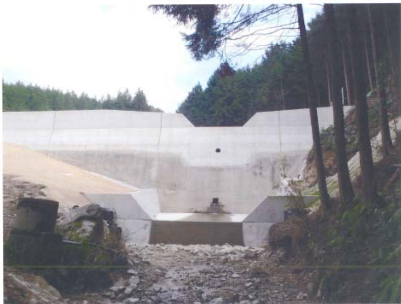
取捨谷止工の嵩上げ：災害関連緊急治山事業（安佐北区可部町上原東山）提供：西部農林水産事務所
