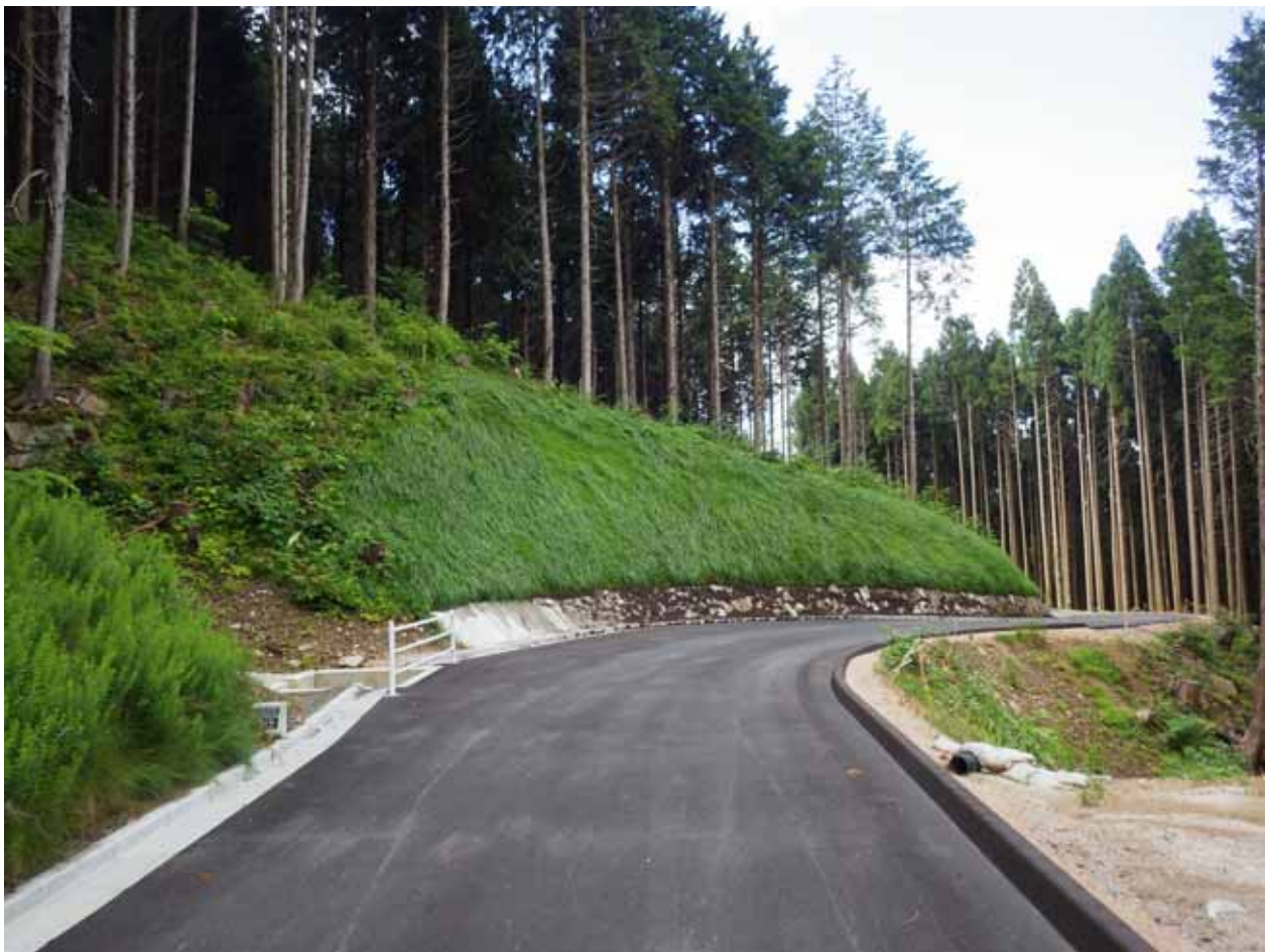
林道界谷小峠その2線 (北部農林水産事務所)
