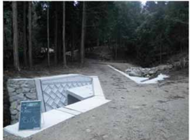
復旧状況(右)。沢筋に集中した雨水により路体が流出。路体及び排水施設(カルバート工)を復旧した。
