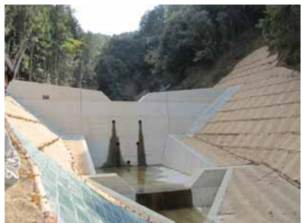
治山えん堤(近景)
