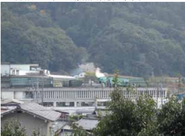
広島市安佐北区大林町(遠筒瀧地区) 治山えん堤及び保全対象
